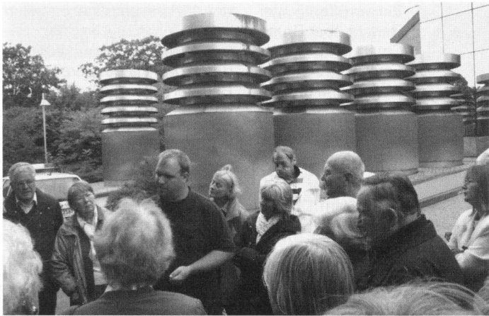
Herr Krey erläutert die Be- und Entlüftungsanlagen des Elbtunnels Foto: R. Wittchen
