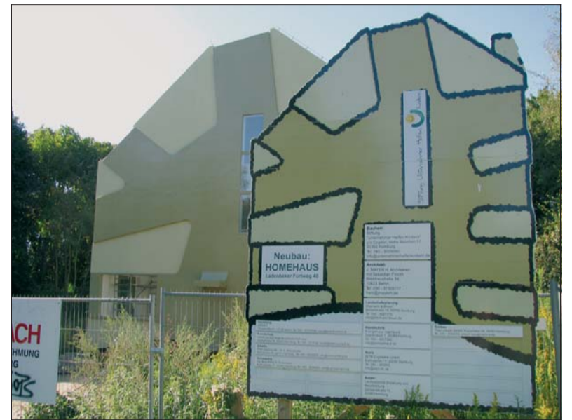
Im Oktober soll das Homehaus bezogen werden.
