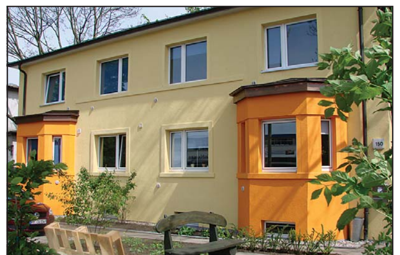
Einladend: In freundlichen, sonnigen Farben präsentiert sich die Erstversorgung für minderjährige Flüchtlinge in der Kollaustraße 150.
