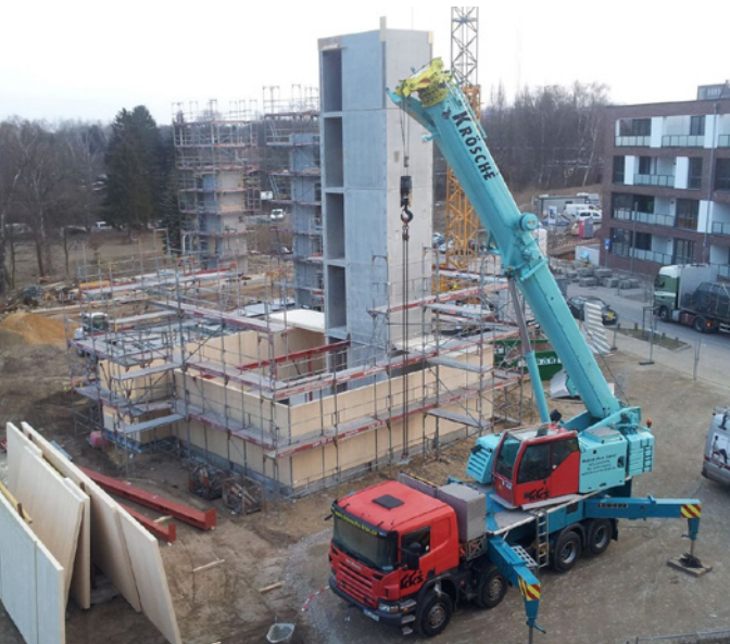
Betonkern der Massivholzhäuser
