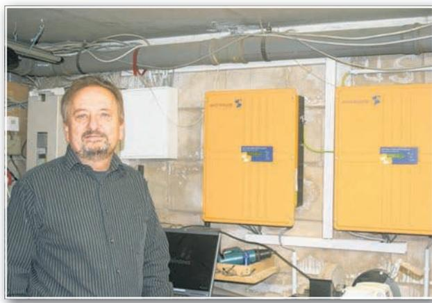
Im Keller von Rainer Ebert sind zwei Wechselrichter angebracht, welche die Gleichspannung in Wechselspannung umwandeln Foto: cd
