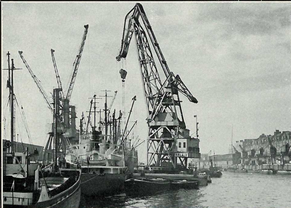
Links im Bild der neue Kaischuppen 10 mit Ladeschiffen und dem 200 t-Schwimmkran — rechts im Hintergrund der neue Speicherblock K am Sandtorkai
