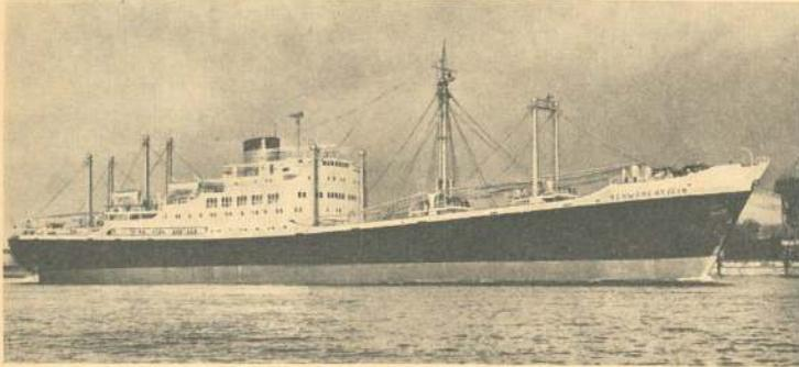
MS „Schwabenstein“ des Norddeutschen Lloyd, 8955 BRT, 163,90×19,40×7,98 m, 2×5280 PS, 17 Knoten. Kombiniertes Fracht- und Fahrgastschiff mit Einrichtung für 87 Passagiere. Erbaut 1954 auf dem Bremer Vulkan, Bremen-Vegesack.
