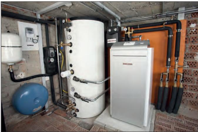
Die Heizungsmodernisierung mittels einer Wärmepumpe reduziert die Heizenergiekosten. Die Umsetzung ist in nahezu allen Häusern möglich, unabhängig vom Wärmeverteilsystem. (Hier eine Wärmepumpe, die Energie aus dem Erdreich gewinnt.) Bild: tdx/Stiebel Eltron
