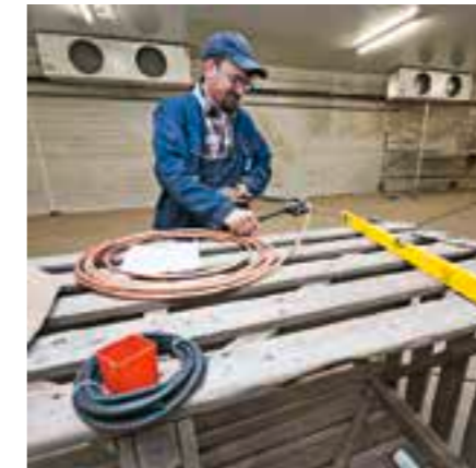
Kälteanlagenbauer Jens Meier beim Biegen von Rohren.
