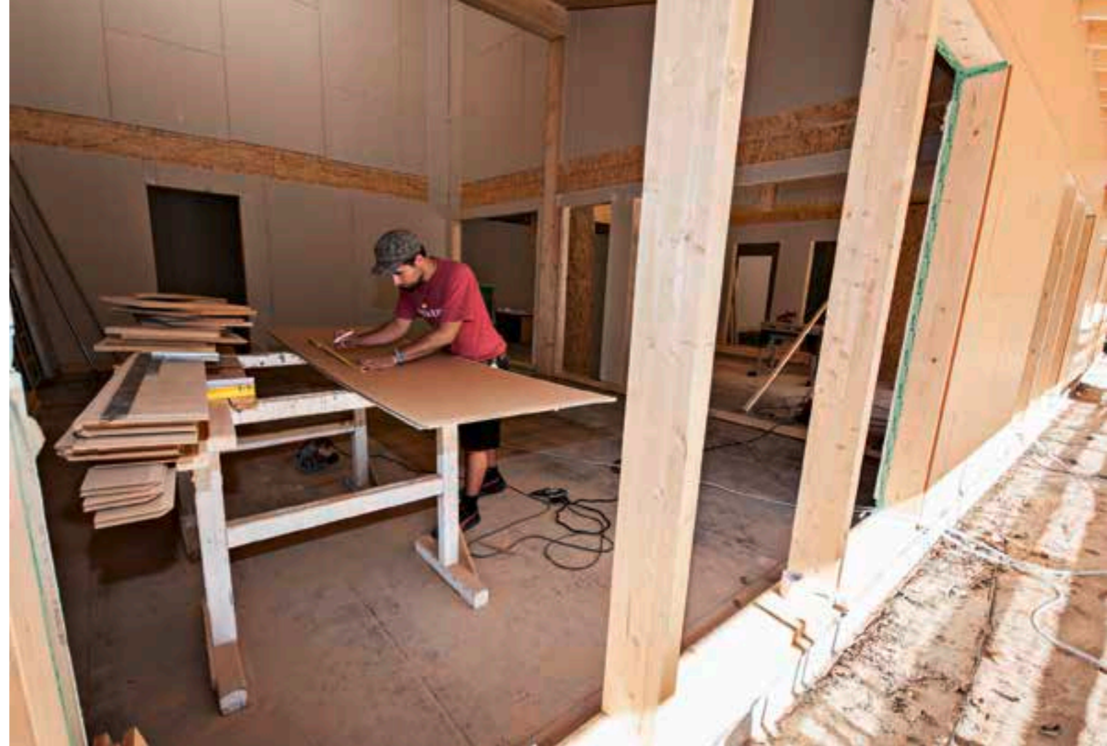
Kitas baut die Zimmerei Stamer aus großen Holzelementen.
