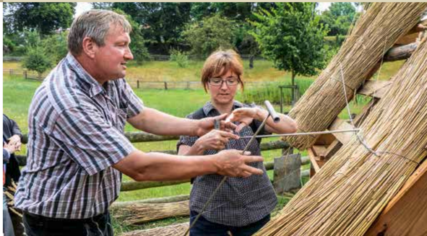
Joachim Schröter zeigt einer Besucherin, wie das Reet auf dem Dachstuhl befestigt wird.
