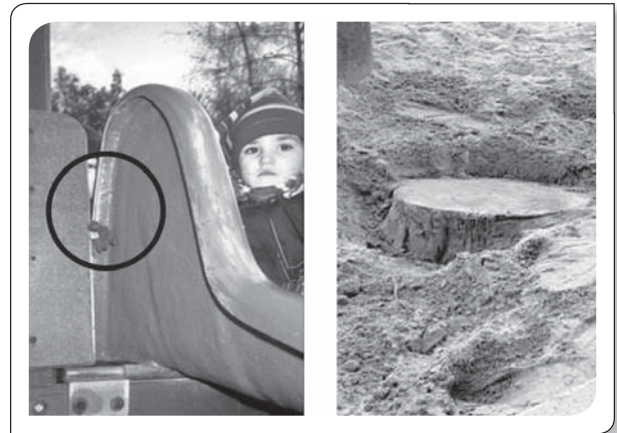
Abb.: Gefahrenquellen bei Spielgeräten: Fangstelle für Kleidung in Zwischenräumen (links), Baumstumpf im Fallbereich rechts). Fotos: Unfallkasse Nord, Standort Hamburg
