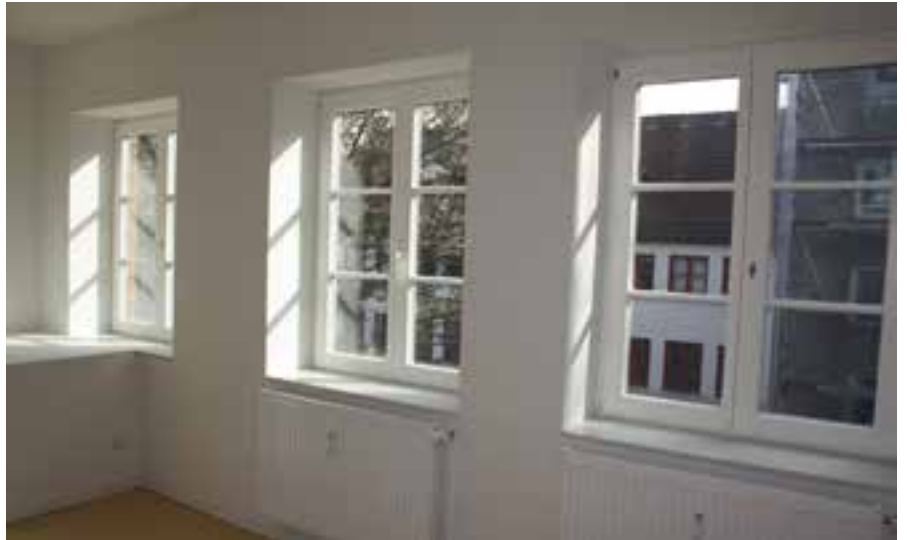
Im bisherigen Dachgeschoss anstatt Abstellräume nun helle Wohnzimmer.
