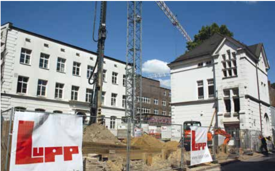
Wohnungen und ein Büro in den früheren Schulgebäuden.
