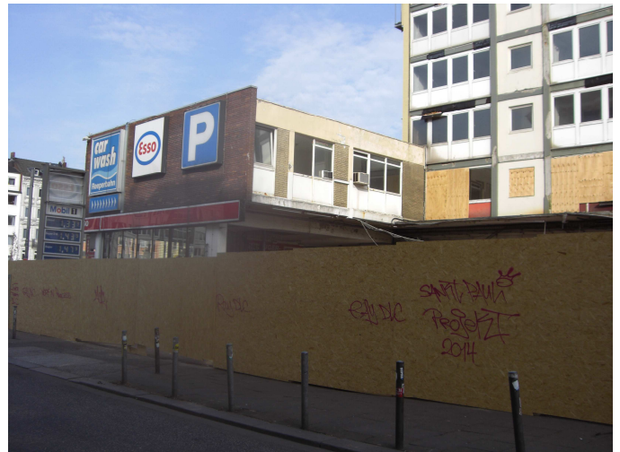
Abriss läuft – die ESSO-Häuser
