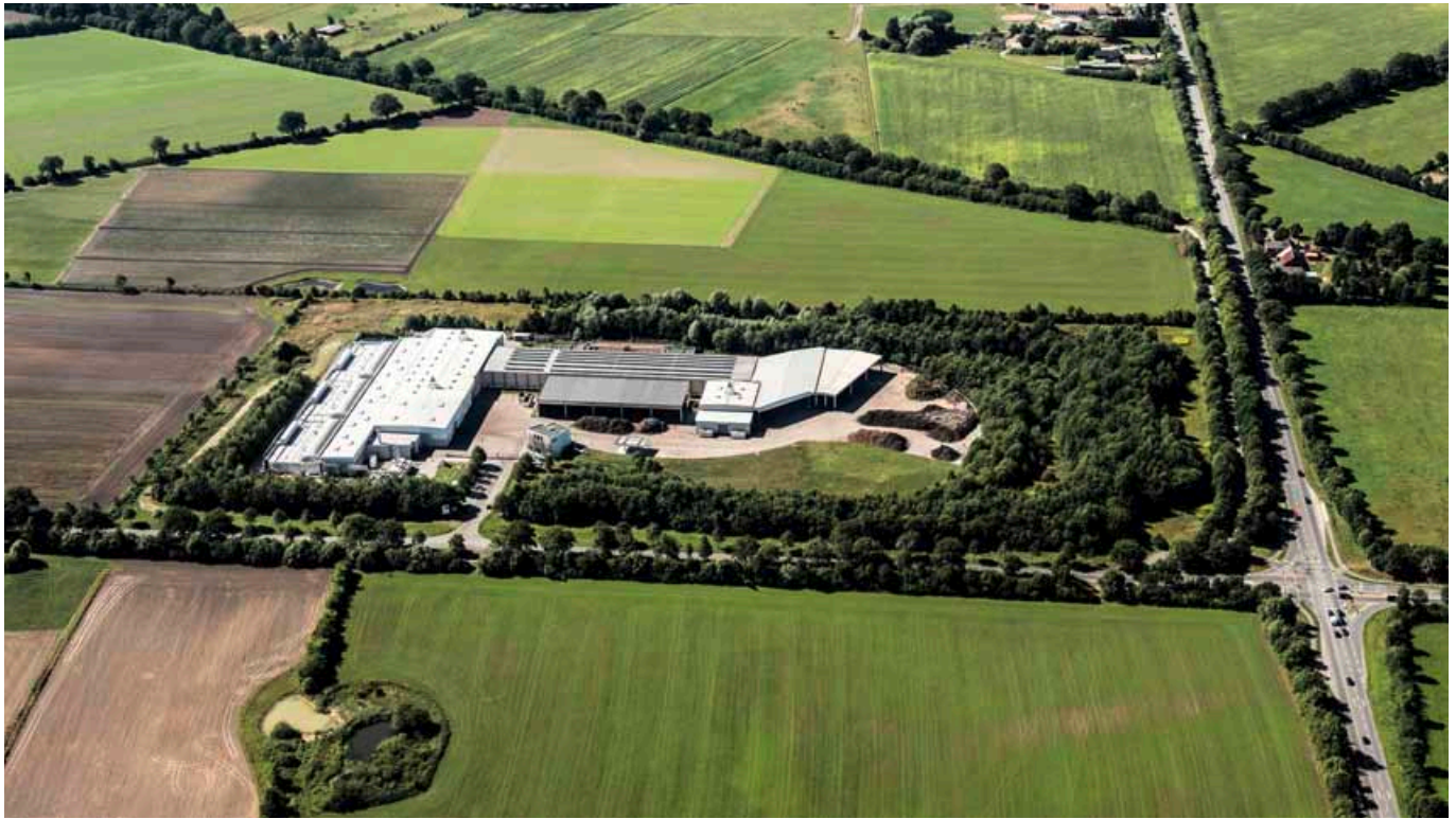
Biogas- und Kompostwerk Bützberg: Abfall aus der grünen Biotonne ist der Wertstoff, den die SRH zu Biomethan in Erdgasqualität veredelt, das sich ins Erdgasnetz einspeisen lässt. In der angeschlossenen Kompostieranlage wird aus den Gärresten hochwertiger Kompost gewonnen.
