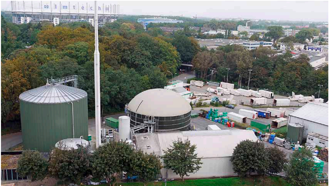
BioWerk zählt zu den größten und modernsten Biogasanlagen Norddeutschlands.
