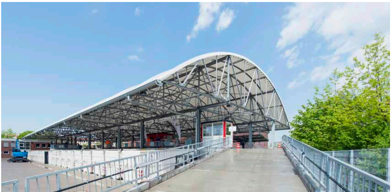
Neuer Recyclinghof Rondenbarg mit servicefreundlicher Anlieferzone
