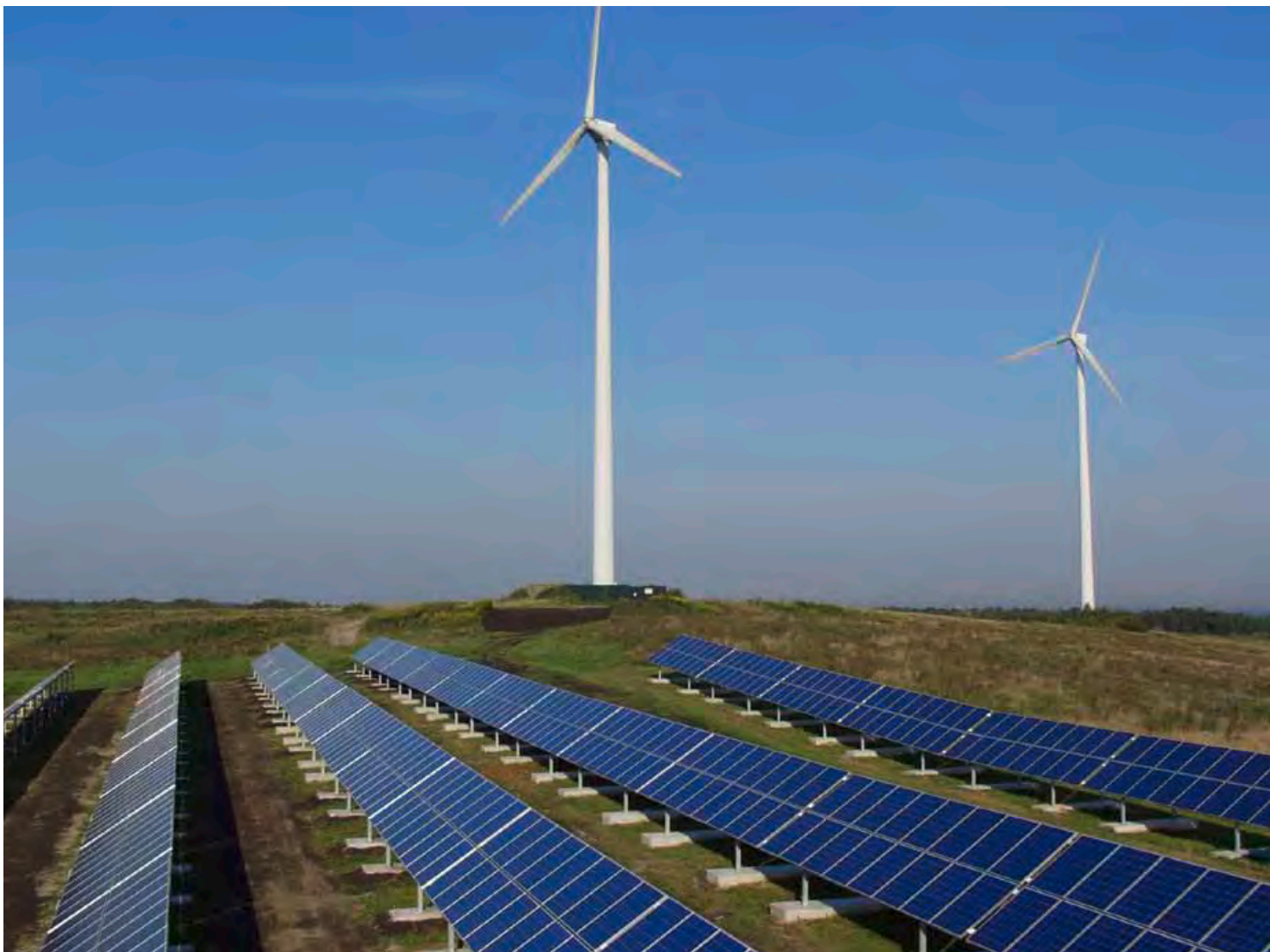
Fotovoltaik- und Windkraftanlagen auf der ehemaligen Hausmülldeponie Neu Wulmstorf
