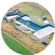
Biogas- und Kompostwerk Bützberg
