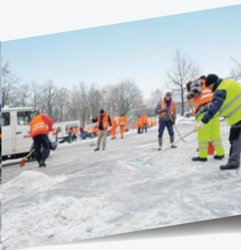
Für zusätzliche Aufgaben war der Winterdienst 2010/2011 bestens gerüstet.
