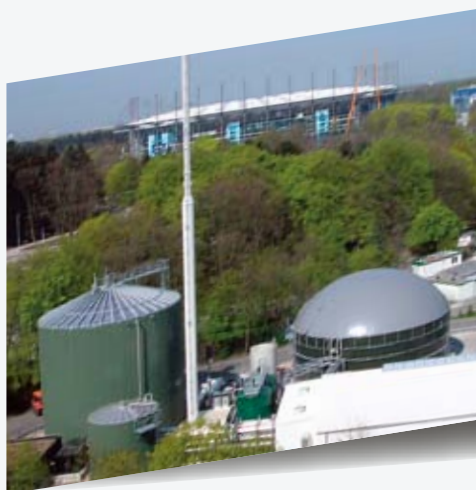
Aus überlagerten Lebensmitteln entsteht in der Biogasanlage neue Energie.
