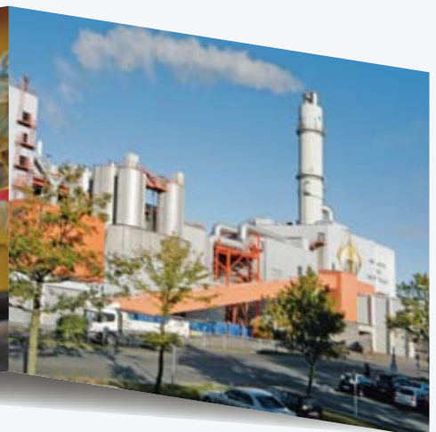
Die eigene Müllverbrennungsanlage macht aus Hausmüll umweltfreundliche Energie.
