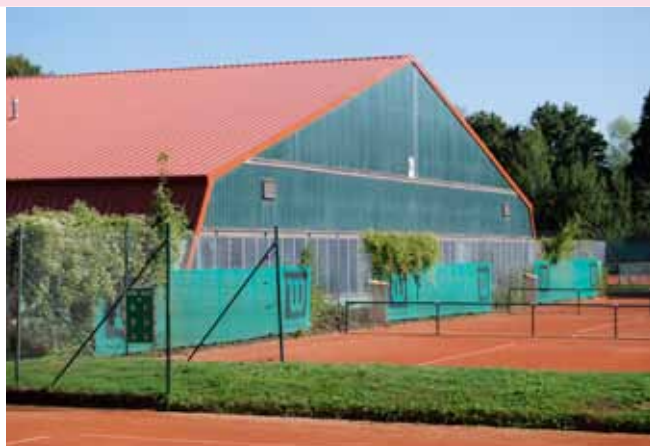
Nach den Sanierungsmaßnahmen erstrahlt die Tennishalle des SC Poppenbüttel in neuem „Outfit“
