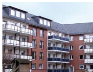
VE 59 nach der Fassadendämmung und dem Anbau der Balkone. Auch hier wurde die Verblendoptik der Fassade erhalten.
