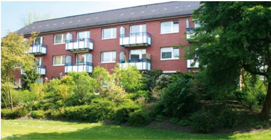
Die Verblendoptik der Fassade wurde erhalten. VE 14, Försterweg in Stellingen, nach Abschluss der Fassadendämmung.
