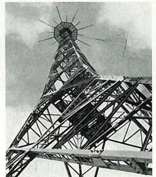
Küstenfunkstelle Norddeich-Radio: Antennenmast 120 m, 25 Antennen, 16 Sender
