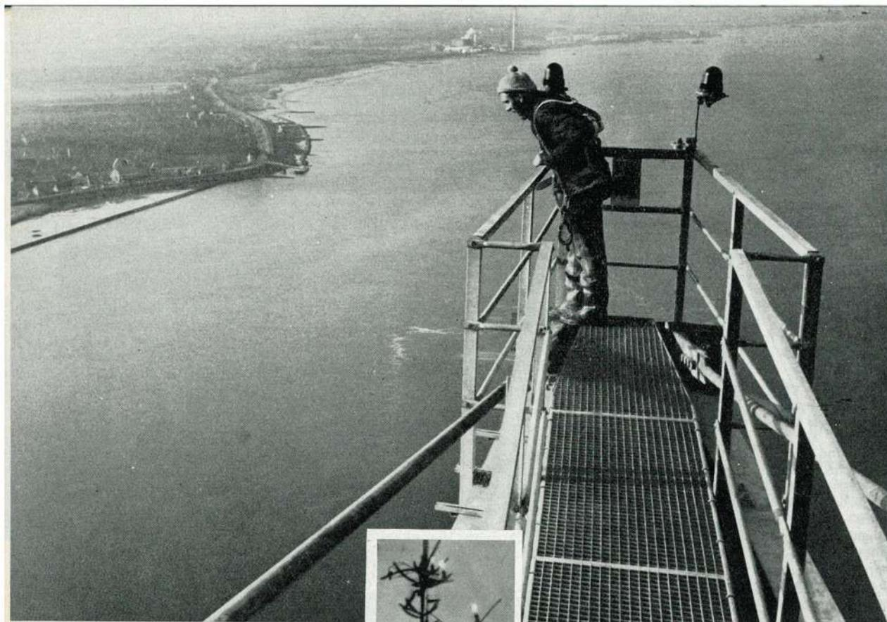
Montage in 200 m Höhe über der Elbe bei Lühesand. Um Schleswig-Holstein mit dem dringend benötigten Kraftstrom aus dem neu errichteten Kraftwerk bei Stadersand zu versorgen, muß die Elbe über ein Strecke von 1140 m überbrückt werden. Das bedeutet Sperrung der Elbe für täglich vier Stunden über einen Zeitraum von drei Wochen. Im Frühjahr sollen die sehr schwierigen Überspannungsarbeiten fortgesetzt werden.
