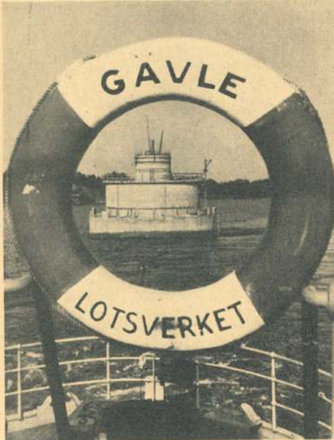
Der Teleskop-Leuchtturm wird in den Bottnischen Meerbusen geschleppt, wo er das Feuerschiff „Grundkallen“ ersetzen soll.
