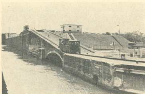
Diese Muli sind zwar klein, aber oho. Spielend tauen sie die dicksten Dampfer in die Schleusenkammern hinein. Es sieht lustig aus, wenn sie die Steigungen hinaufklettern oder hinabgleiten.
