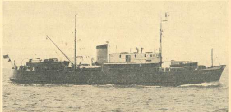
Das bekannteste Vermessungsschiff des D.H.I. ist das MS „Gauss“, 1941 von D. W. Kremer Sohn, Elmshorn, erbaut. 846 BRT, 56,60x8,82x3,95 m. 1000 PS, 12 Knoten.
