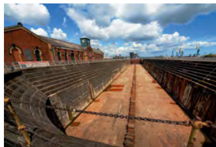
BAUPLATZ: Im Thompson-Trockendock wurde die „Titanic“ nach dem Stapellauf fertig ausgerüstet.
