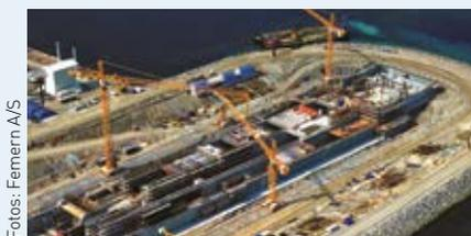
**TROCKENDOCK: Fertigung der Tunnelelemente.**
