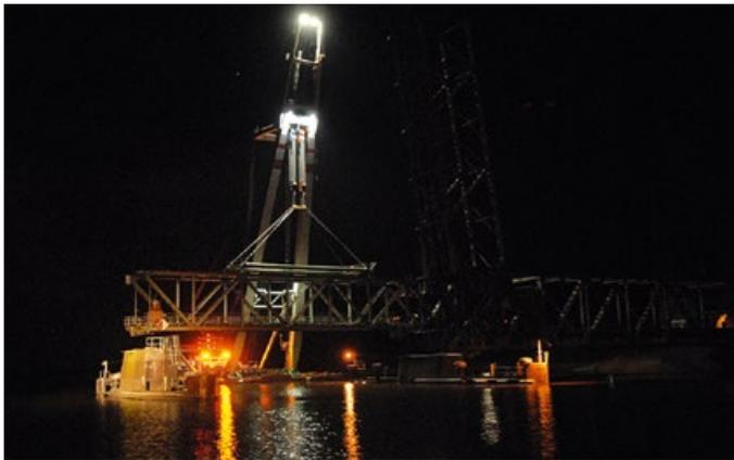
**WEENER:** Die Friesen-Eisenbahnbrücke wird für den Transfer nicht nur hochgeklappt, sondern auch teilweise demontiert.
