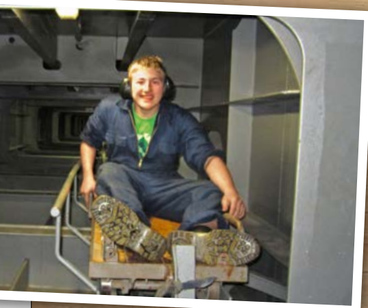
Trockenübung: Die „U-Bahn“-Test eines Bilgenalarms.
