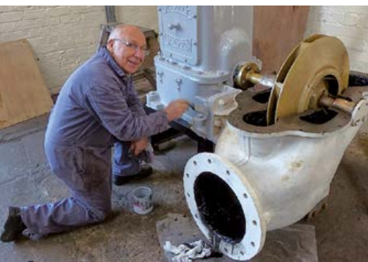
ANSTRICH: Antike Bauteile werden restauriert.
