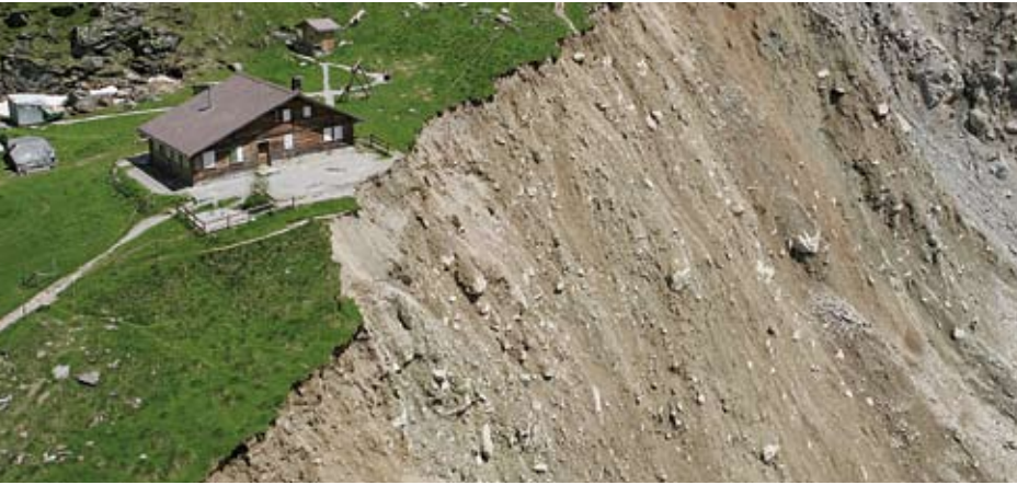
Rund 500.000 Kubikmeter Felsmaterial rutschten im Mai 2005 beim Oberen Grindelwald-Gletscher zu Tale.
