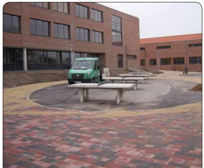
Abb. 13: Neubau Gymnasium Schwarzenbek, Januar 2008 Quelle: http://www.gymnasium-schwarzenbek.de/
