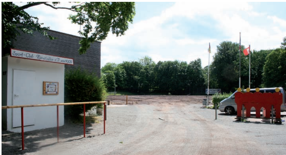
In nur acht Wochen wird der große Grandplatz des SC Nienstedten mit Rollrasen versehen
