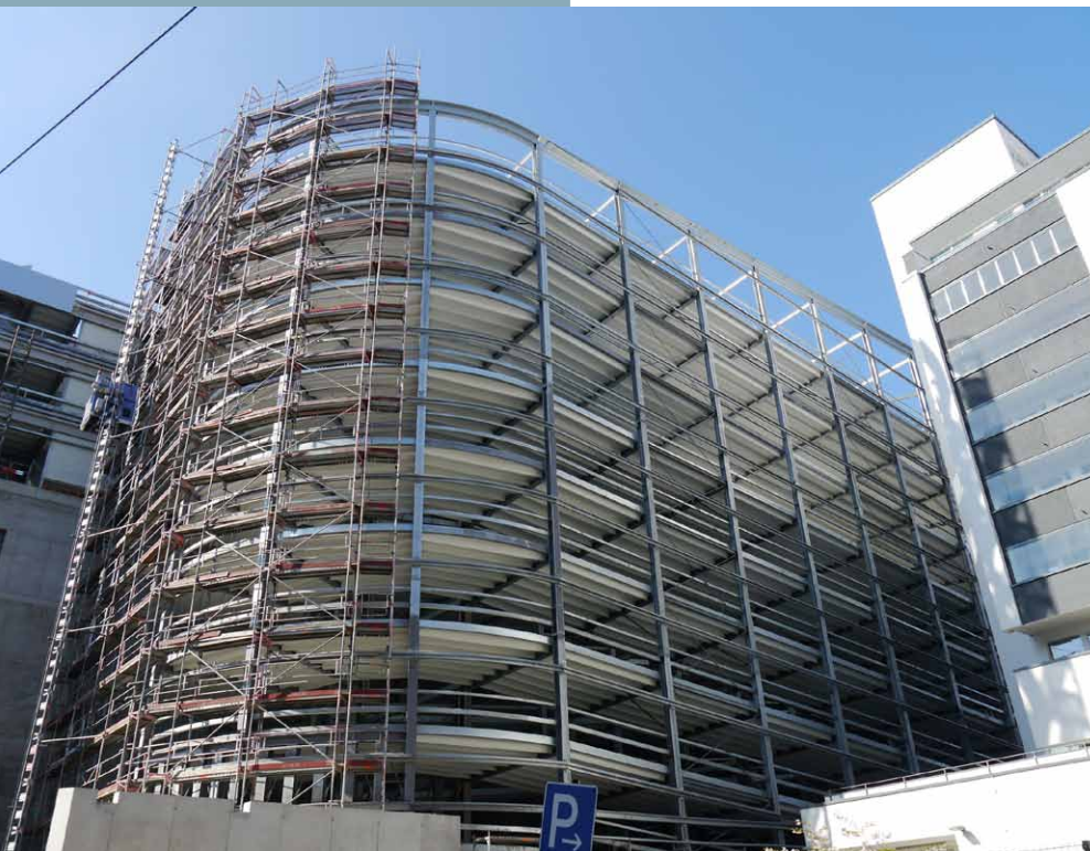
Bauarbeiten an der Parkhausspindel
