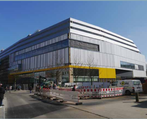
Fassadenarbeiten stehen kurz vor dem Abschluss
