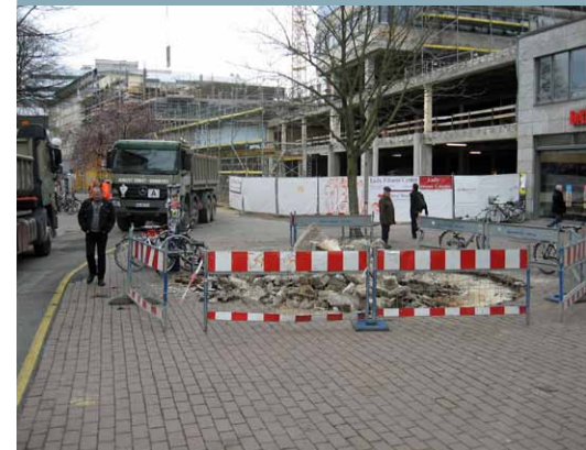
Demontage der ehemaligen Brunnen
