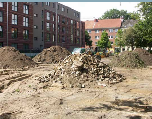
Im Erdreich gefundene Altlasten und Mauerreste
