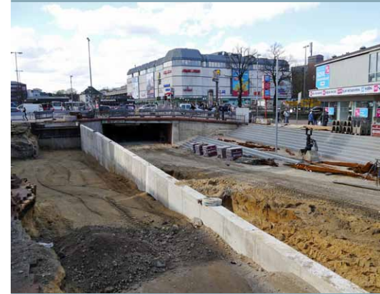
Rampenanlage zur Neuen Großen Bergstraße
