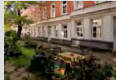
13 Falkenried Terrassen, Hoheluft
