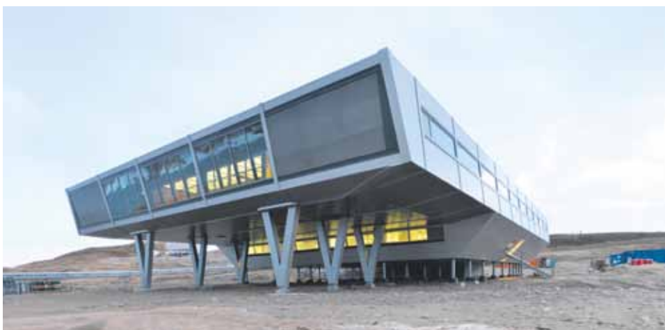
Zwei Schichten dreifach verglaster Fenster schützen vor den arktischen Winden
