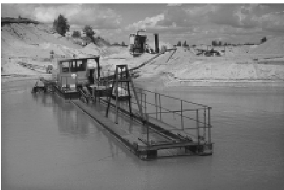
Abb. 69: Nassabbau mit Saugbagger
