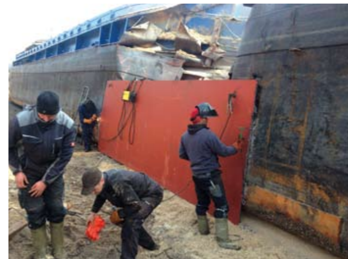
Das riesige Loch wurde zunächst mit einer Stahlplatte zugeschweißt
