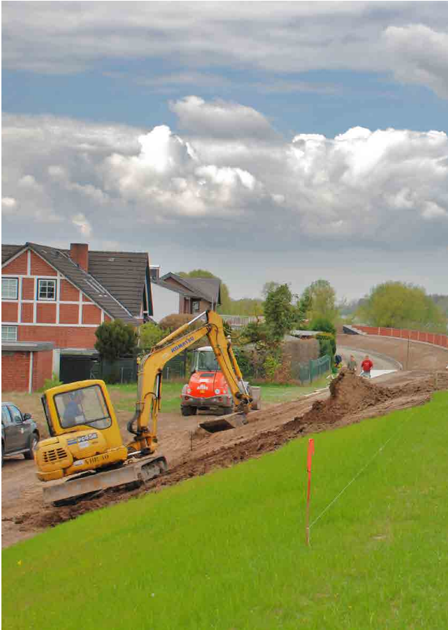
Abb.7.1.4: Arbeiten am Deich an der niedersächsischen Elbseite (C. Remmersmann)
