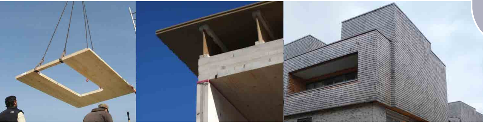
Abb. 5.8.1: (links und mitte) Bau des Versuchshauses aus Massivholz auf FH-Campus (G. Conradi) Abb. 5.8.2: (rechts) Dachaufstockung am Beispiel der „Treehouses“ Bebelallee 64-70 in Hamburg (S. Slama).
