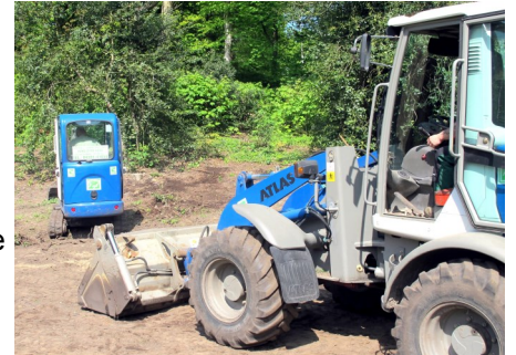
Schweres Gerät im Einsatz
