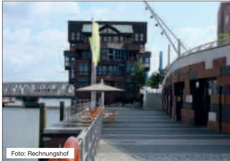
Foto: Rechnungshof Blick von der nördlichen Promenade Magdeburger Hafen auf das Gebäude Osakaallee 11
