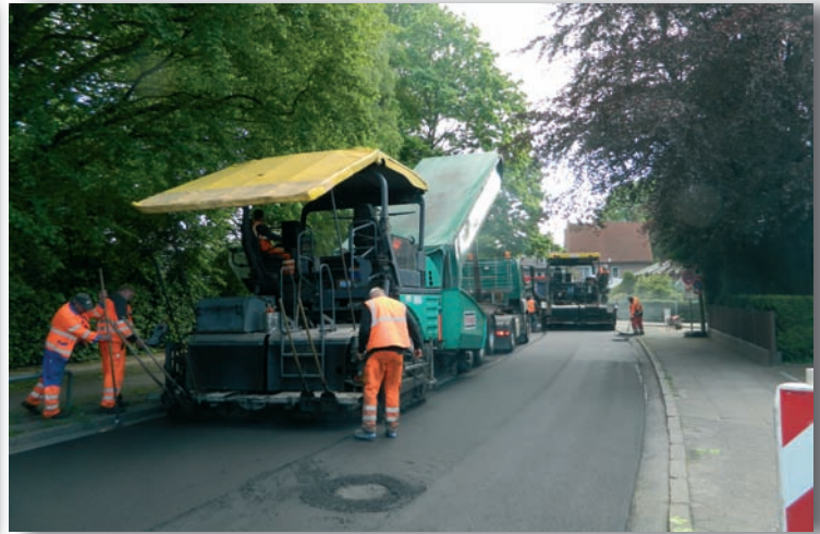
zwei Maschinen verlegen gleichzeitig den Asphalt
