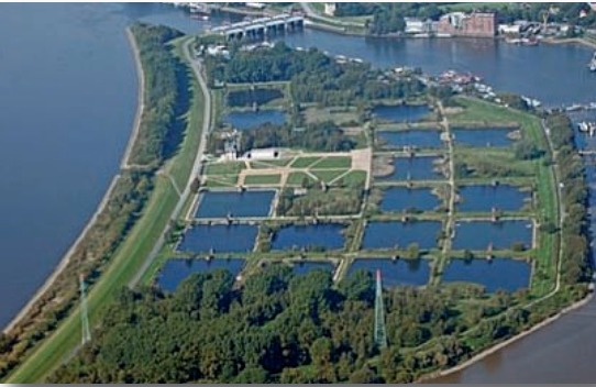
die Becken der früheren Wasseraufbereitung für Hamburg
