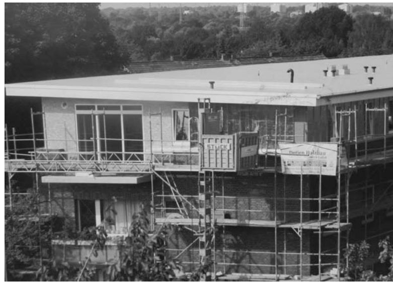
Aufstockung eines bestehenden höheren Hauses
