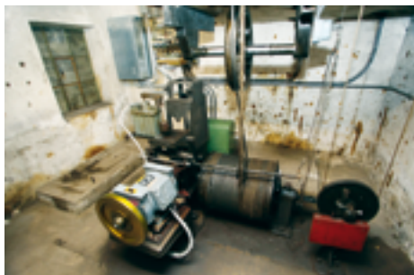
Das Herzstück des Aufzugs. Ein Elektromotor, der kurz nach dem 1. Weltkrieg fabriziert wurde und Stahlseile, die regelmäßig ausgetauscht werden.
