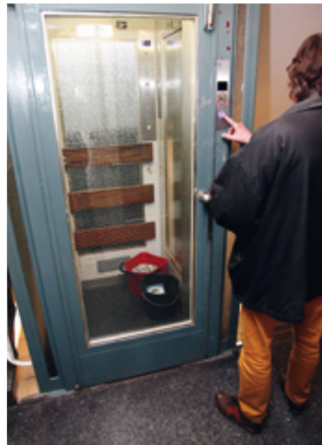
Bange Mieterfrage: Führt er heute oder streikt er wieder. In die Jahre gekommenen Personenaufzug im Hochhaus Buschrosenweg 24
