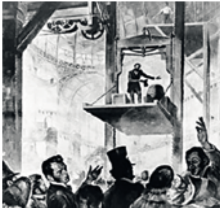
Mister Otis demonstriert höchstselbst, dass seine Fahrstuhlkonstruktion nicht absturzgefährdet ist: „All safe, Gentlemen, all safe.“
