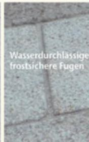
Wasserdurchlässige, frostsichere Fugen
