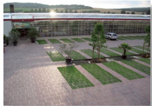
len Bereich, mit dem TTE®-System werden Parkplätze und Zufahrten zu natürlichen Versickerungsflächen für Niederschlagswasser. So fördern TTE®-Flächen die Grundwasserneubildung, haben einen positiven Effekt auf stadtklimatische Verhältnisse und sparen Kosten zur Errichtung von Rückhaltebecken und größeren Kanälen.
