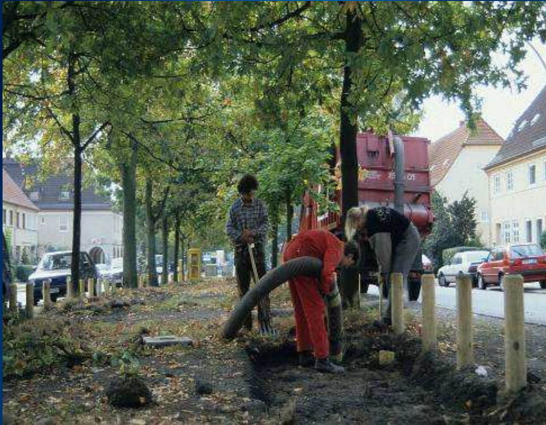
Entfernen von Versiegelungen bzw. wurzelschonender Bodenaustausch
