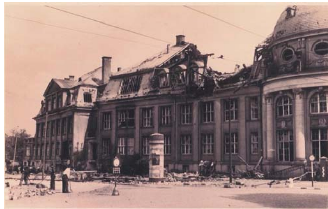
Bombenschäden am Ostflügel, 1944 (Archiv Bucerius Law School)
