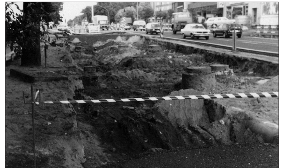
Der vierspurige Ausbau der Cuxhavener Straße
