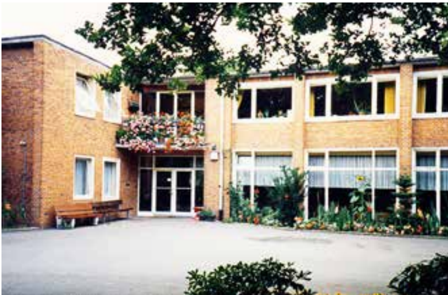
Das Haus liegt am Rande des Jenfelder Moors, umgeben von Einfamilienhäusern.
