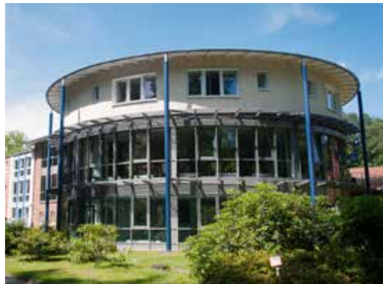
2003 ging der Neubau mit Cafeteria, Physiotherapie-Räumen, Bewegungsbad, Fitnessbereich und Sauna sowie Patientenzimmern in Betrieb.
