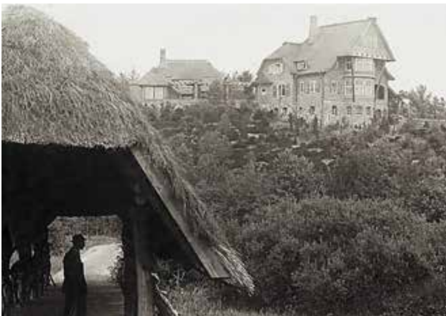
Der Hamburger Juwelier Franz Barca baute sich 1910 einen Landsitz in der Nordheide. 1939 errichtete die Landesversicherungsanstalt dort ein Kinderheim, 1979 eröffnete dann die Stiftung das Fachkrankenhaus Hansenbarg.
