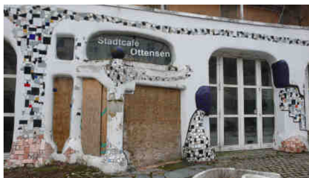
Der Eingang des Hundertwasser-Cafés wird der Blickfang einer neuen Wohnanlage
