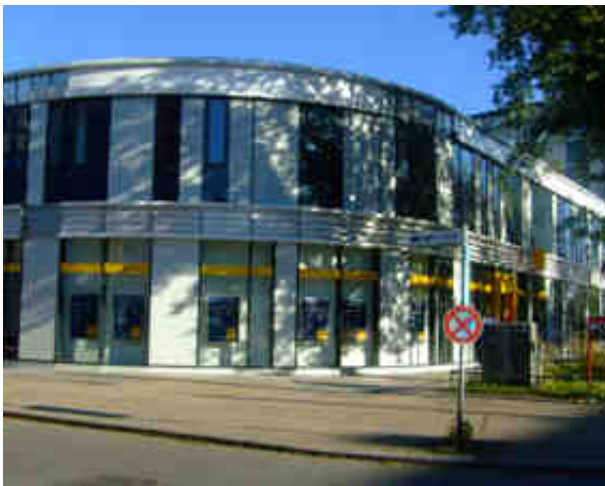
Der erste Bauabschnitt des Lurup Centers ist fertig, die Filiale der Post plus Postbank ist schon eingezogen.
