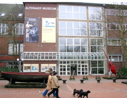
Altonaer Museum und Altonaer Theater hilft die heutige Verkehrsregelung. Eine attraktive Vorplatzgestaltung fehlt aber aufgrund knapper Kassen im Bezirksamt nach wie vor.
